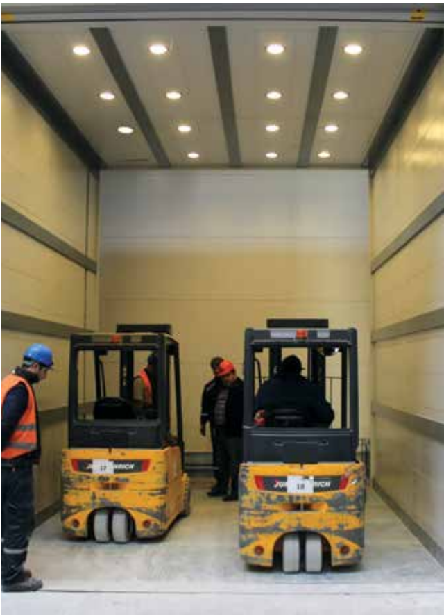
Hydraulic lift (rated load 10.000 kg) Гидравлический лифт (грузоподъемность 10.000 кг)
