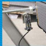
梯级链断裂保护装置 Step-chain breaking protector
